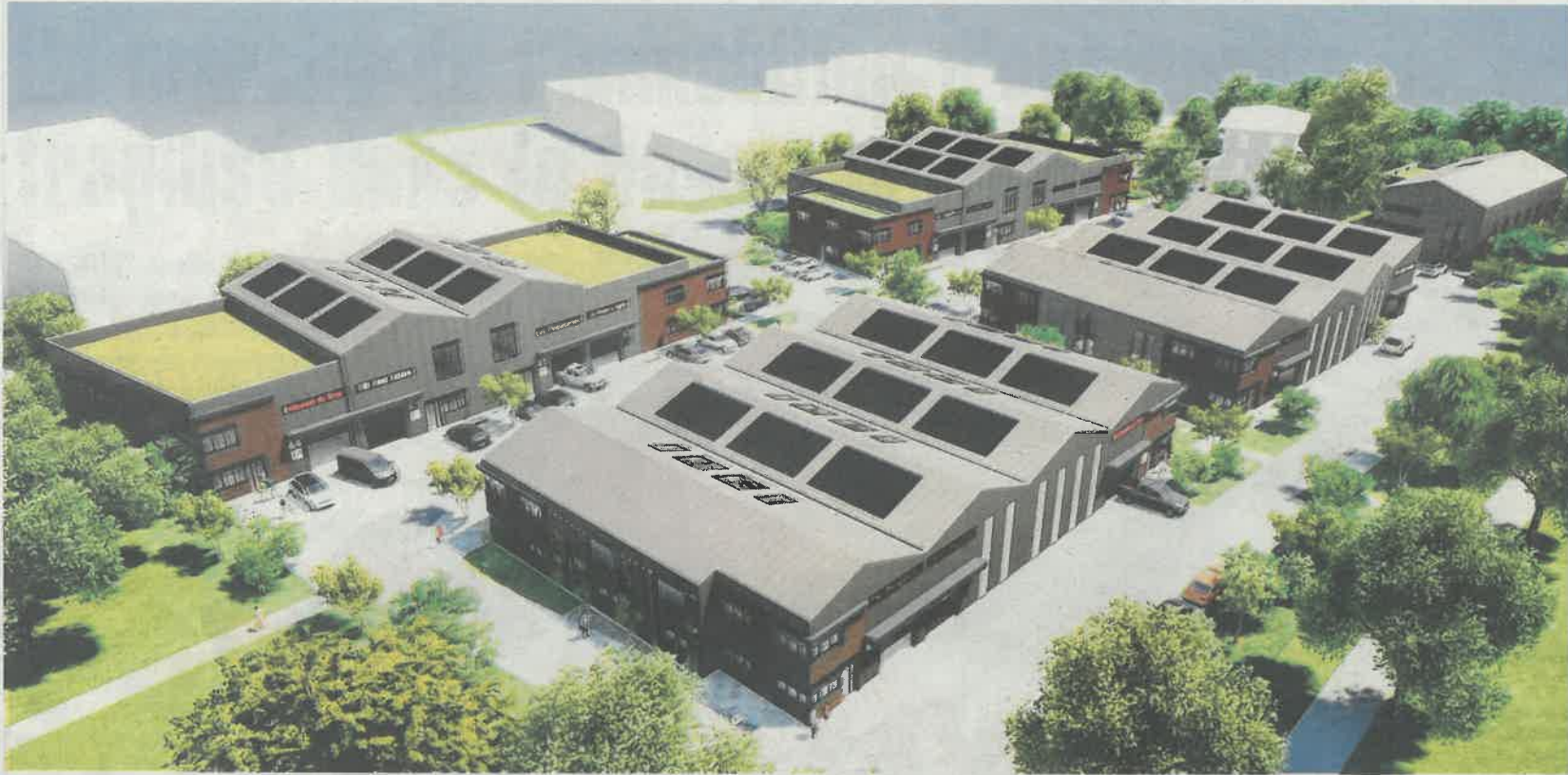
Seule opération de locaux d'activités neuve lancée sur le bassin grenoblois en 2023, Espace Papeteries propose 6 400 m 2 (divisibles en 17 lots à la vente et à la location) aux entreprises de production industrielle sur le site des anciennes Papeteries du Pont-de-Claix. ©PHOTO CABINET ARA GRANGE SCRITTORI
